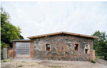
HÜTTEN & PALÄSTE Scheune Prädikow, Umbau, genossenschaftliches Wohn- und Gewerbehaus, Prötzel Foto: Studio Bowie
