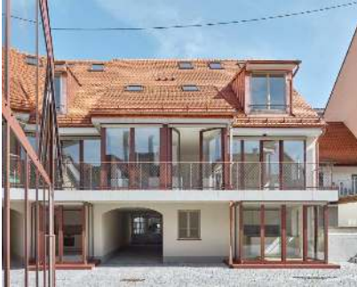
STEPHANIE HIRSCHVOGEL Sanierung und Umbau "Grünes Haus", Schongau Foto: Philip Heckhausen
