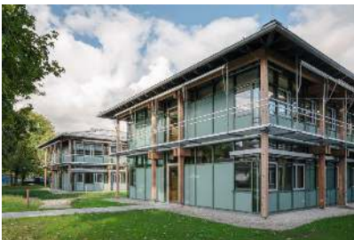
AUER WEBER ASSOZIIERTE Erweiterung Landratsamt Starnberg Foto: Aldo Amoretti
